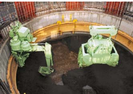
写真-1 自動水中掘削機
