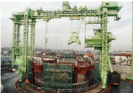
写真-2 揚土機全体（橋型）
