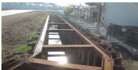
写真-1 周辺状況（工事前）
