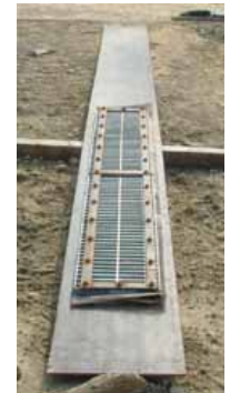
写真-2 透水フィルター板
