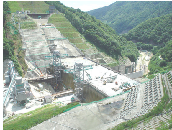
写真-1 長井ダム施工状況
