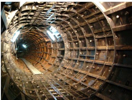
写真-3 拡幅施工後断面
