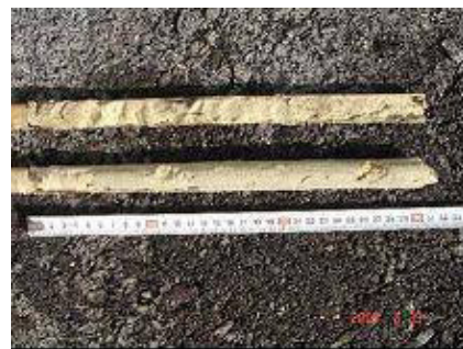
写真－2 採取器による充填確認
