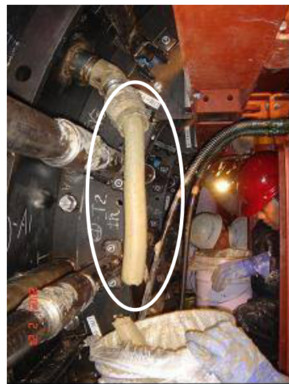
写真－3 充填材回収状況
