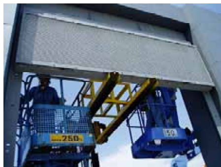
写真 - 5 越波柵施工状況
