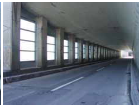
写真 - 6 越波柵完成状況
