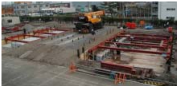
図 - 2 実験ヤード写真
