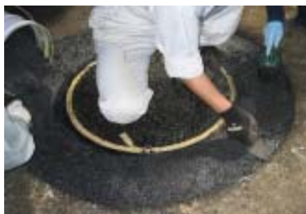
写真-4 鉄蓋周辺材の施工状況
