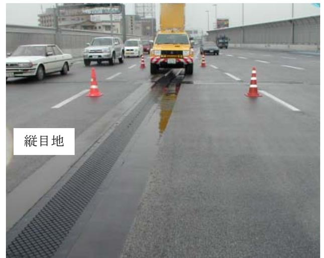
写真-1 縦目地(ゴム製伸縮装置)
