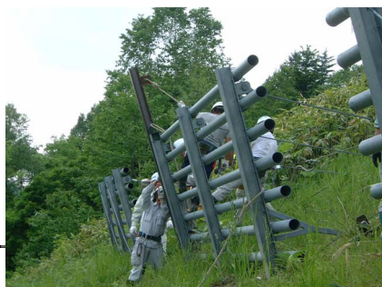
写真-2 現地設置状況
