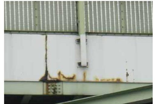
図-1 鋼製高欄損傷
