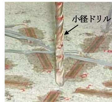
写真-4 小径ドリルによる削孔状況
