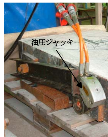
写真-2 PC 鋼棒の緊張状況
