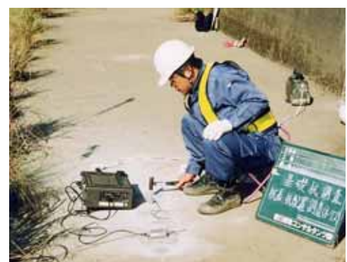
写真—1 探査状況
