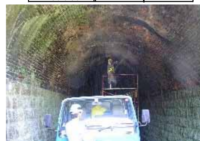
写真-1 施工状況（吹付け）
