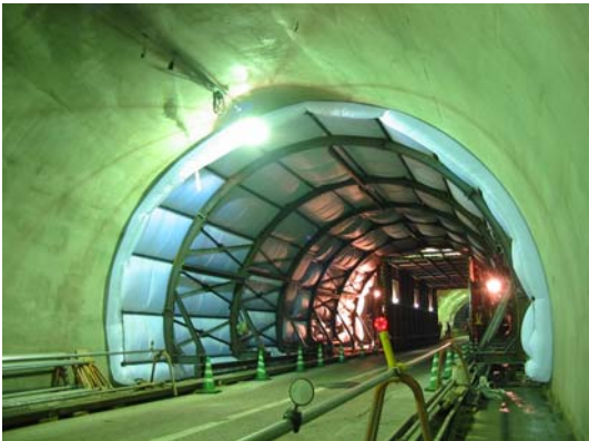
写真-2 トンネルバルーンによる養生
