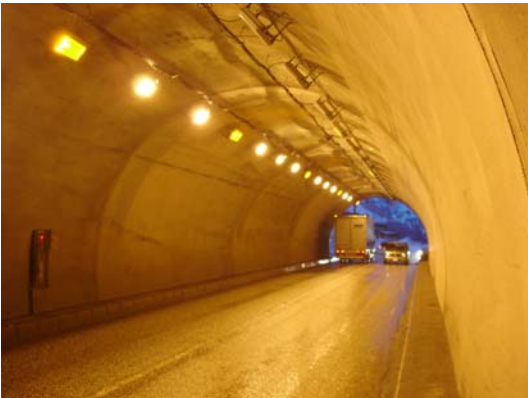
写真-3 繊維混入高流動コンクリート仕上り状況
