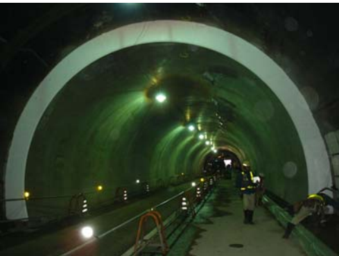
写真-4 覆工コンクリート復旧区間の全景
