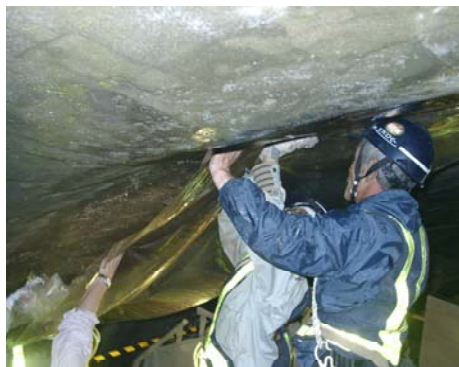
写真-2 貼付状況
