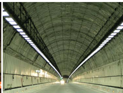
写真-4 完成状況
