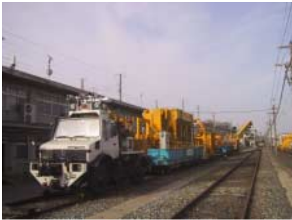
写真-2 坑内プラントの概要
