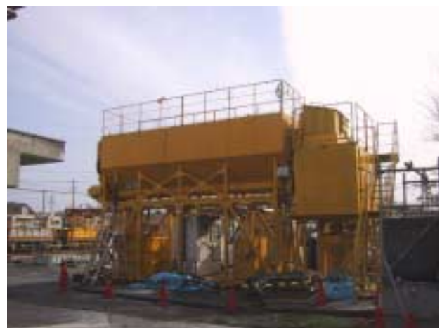
写真-1 坑外プラントの概要
