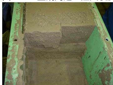
図-8 コンクリートブロック周辺の充填状況
