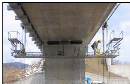
写真－6 PC橋での試行状況
