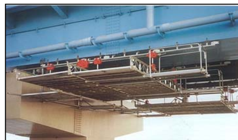
写真-3 移動吊足場全景
