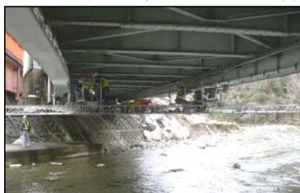
写真－4 鋼橋での試行状況
