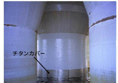
写真-3 チタンカバー設置状況
