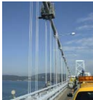
写真-1 吊橋ハンガーロープ
