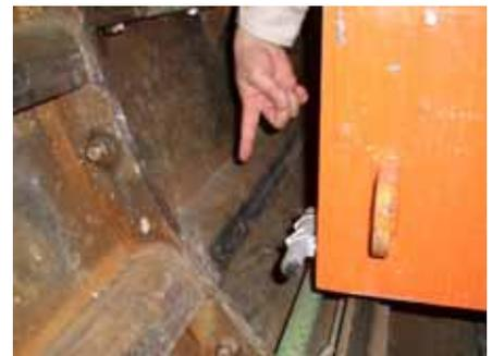
写真-2 セグメントに取付けた IC タグ
