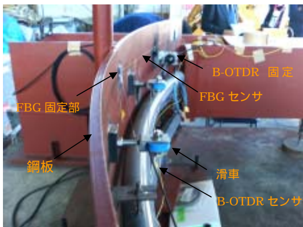
写真1 光ファイバセンサ設置状況
