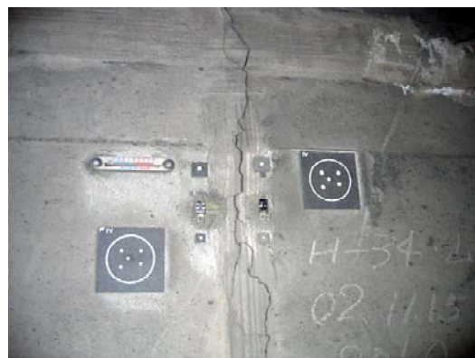
写真-3 ターゲット設置状況
