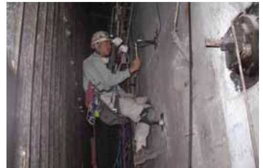
写真-1 調査状況
