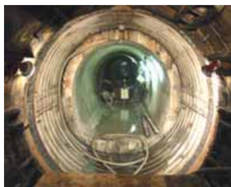
写真4-1 地中接合完了状況
