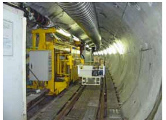
写真-2 遠隔測量システム
