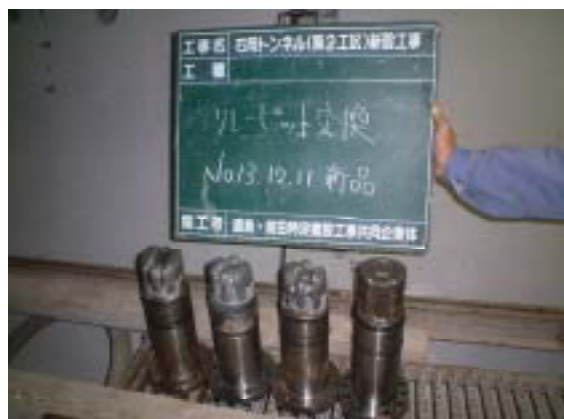
写真-3 3,800m 地点リレービット交換状況
