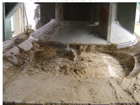
写-1 切削面の状況
