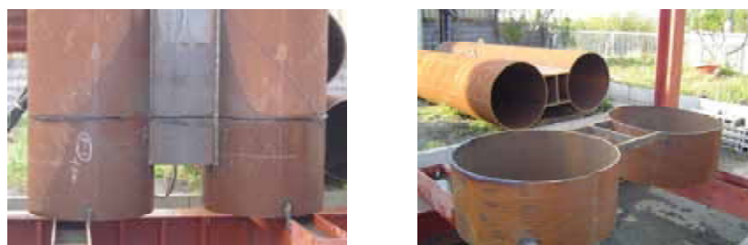
図-5 砥石カッター切断機によって切断された連結鋼管矢板
