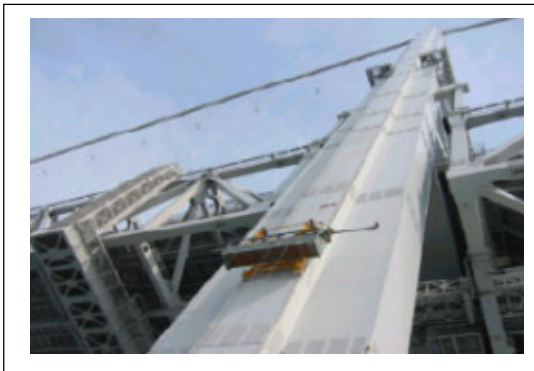
写真－2 塔柱外面の塗替作業状況
