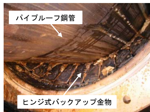
写真－2 発進エントランス
