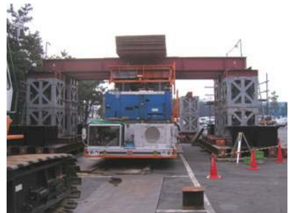
写真-2 架設試験状況（JES継手）
