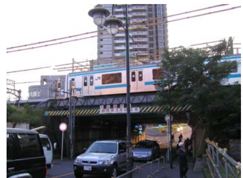
写真-1 現在の架道橋例
