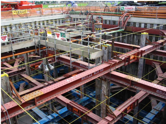
写真-1 施工状況
