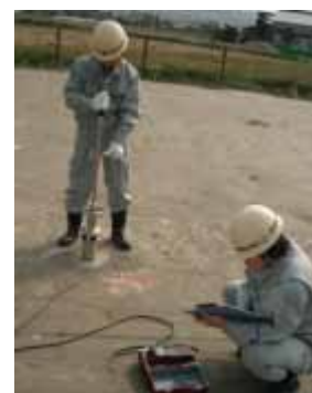
写真1 小型FWD試験状況
