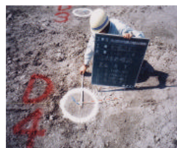
写真 1 杭径確認状況
