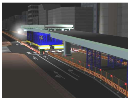
図-5 中央径間部の一括架設イメージ
