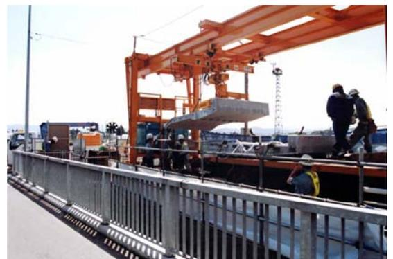
写真-2 PC床版架設状況
