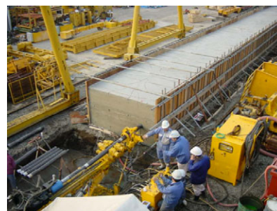
写真-2 実証試験状況
