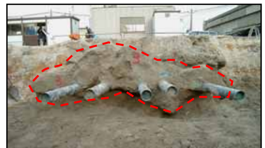
写真-2 模擬地山による注入実験
