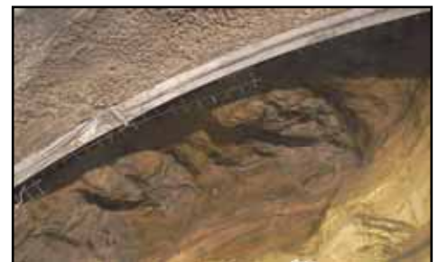
写真-4 天端改良状況
