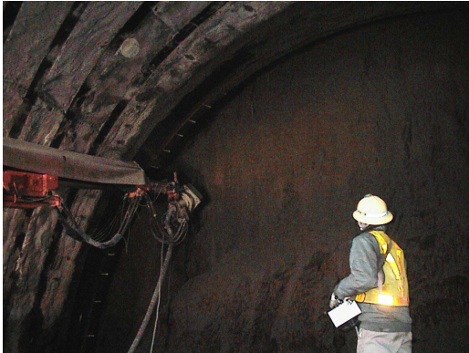
図-3 吹付けコンクリート施工状況
