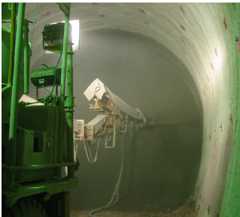
写真－1 吹付け実験状況
