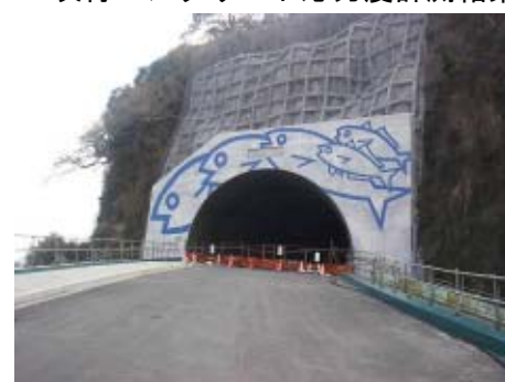
図6 斜坑門全景（塗装後）
