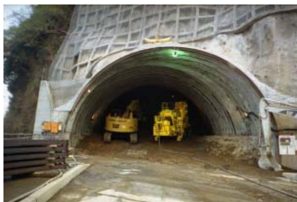
図3 坑口部掘削状況
