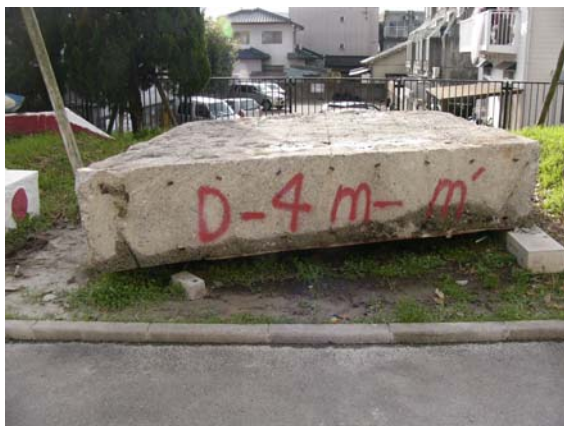
図-2 祇園橋解体コンクリート
