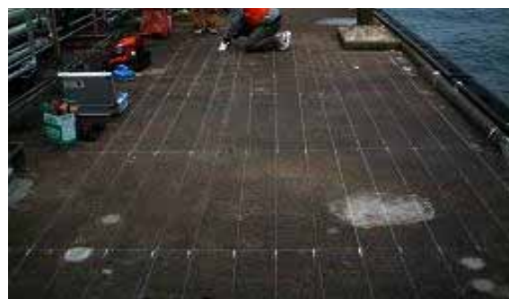
写真-1 電磁波による測定状況写真
