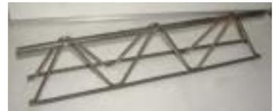
図-1 トラス鉄筋
