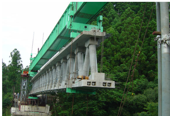
写真－2 架設状況
