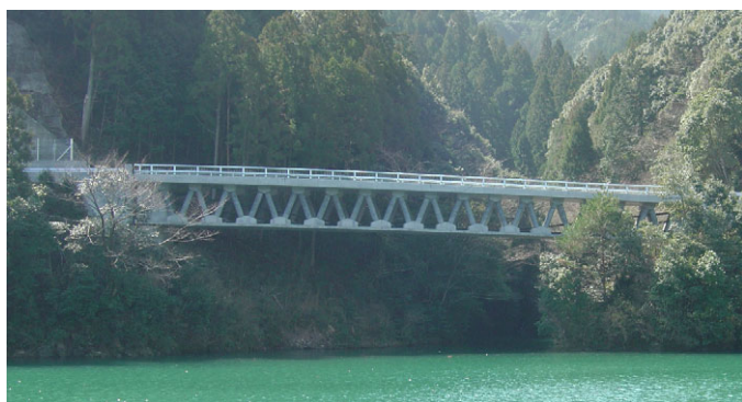
写真－1 鎌山谷橋全景
