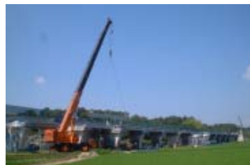
写真-1 架設状況
