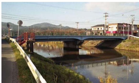
写真-1 着工前全景
