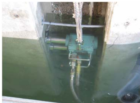
写真－3 PC鋼より線の緊張
